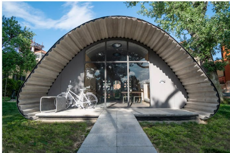
Une maison construite en béton à faible teneur en carbone ECOPact de Holcim. Chiara Becattini
