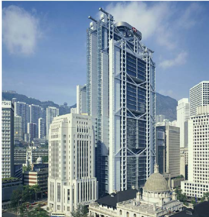
El edificio del Hong Kong and Shanghai Bank (1986) es uno de los epílogos de la arquitectura high-tech y el trabajo que dio fama internacional a Norman Foster.
