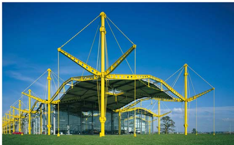
Avec les poutres jaunes en acier du Renault Distribution Centre à Swindon, Foster reprend une technique utilisée dans l'automobile par la marque britannique Lotus. © Foster + Partners
